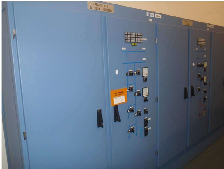
Slika 27: Omari vodenja, zaštite in tehnoloških meritev obstoječega polja
