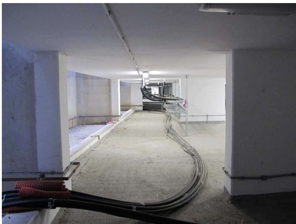
Slika 20: Potek 110 kV kablov v kabelskem prostoru
