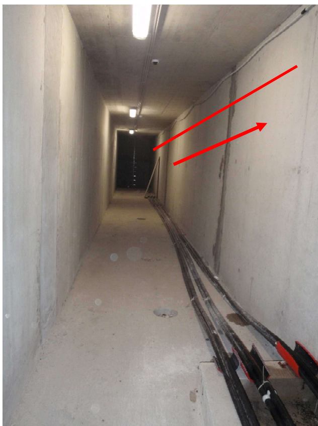
Slika 19: Potek 110 kV kablov v kabelskem hodniku
