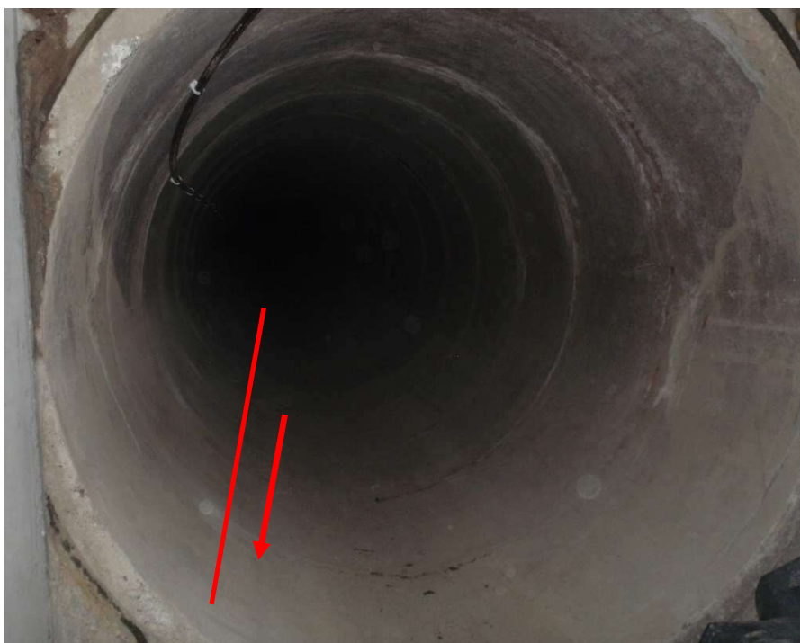
Slika 18: Potek 110 kV kabelske trase v betonski cevi pod Šmartinsko cesto
